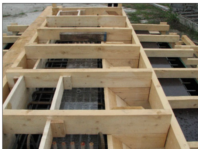
14. kép: Aszimmetrikus próbaszalu
