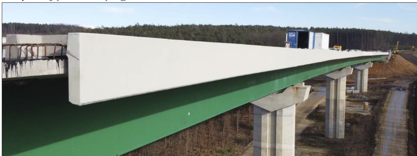
22. kép: Hídszegély a vasszentmihályi völgyhídon
