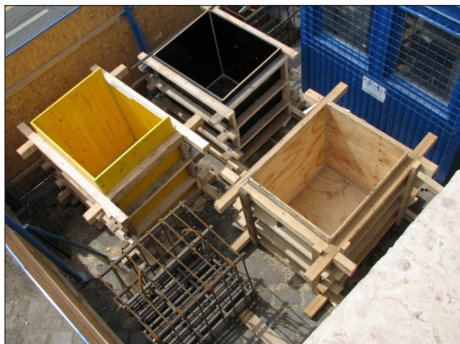
7. kép: A felületi próba zsaluzatai
