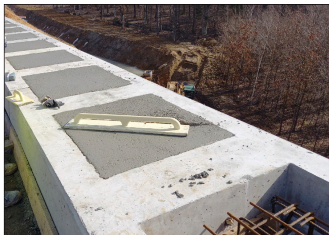
20. kép: Monolit tömb felső síkjának lehúzása az előregyártott szegély felső síkjával egy szintre
