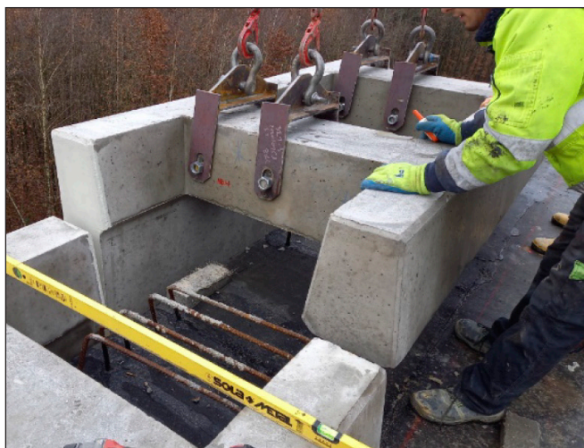
18. kép: Szegélyek elhelyezése betonékek segítségével
